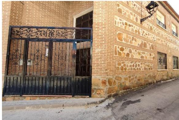
Los trabajos para dotar de un acceso accesible a la sala de la planta baja consistirán en utilizar el hueco de una de las ventanas de la sala de las dos de las que dispone a la cl. Tejar, eliminando el antepecho y convirtiendo el hueco en puerta de acceso a nivel de la calle.
